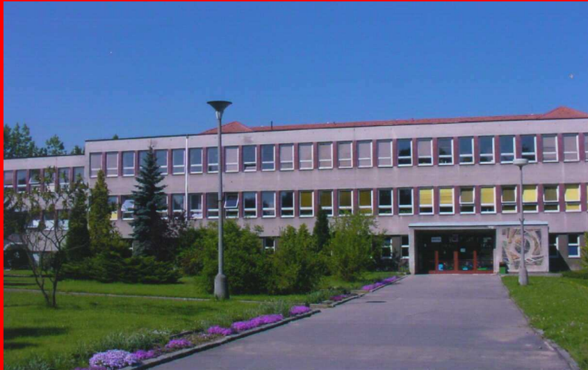
☛ Před rekonstrukcí – rok 2006
